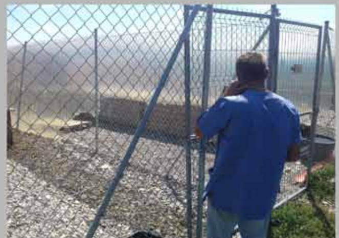
Reparatur der Zäune
