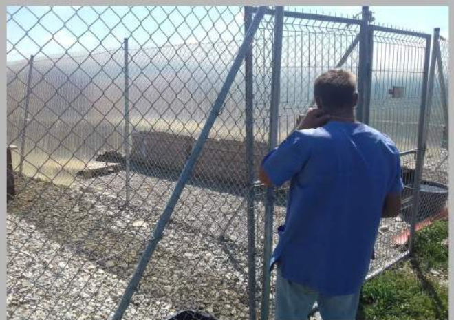
Reparatur der Zäune
